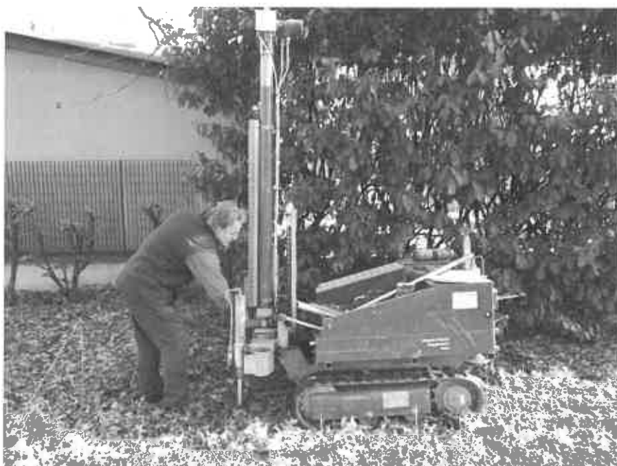
Foto 4: Esecuzione prova scpt
