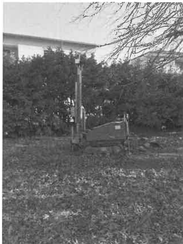
Foto 6: Esecuzione prova scpt
