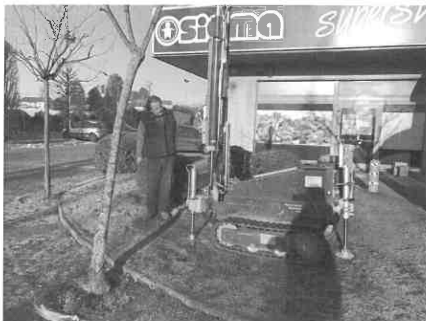
Foto 3: Esecuzione prova scpt
